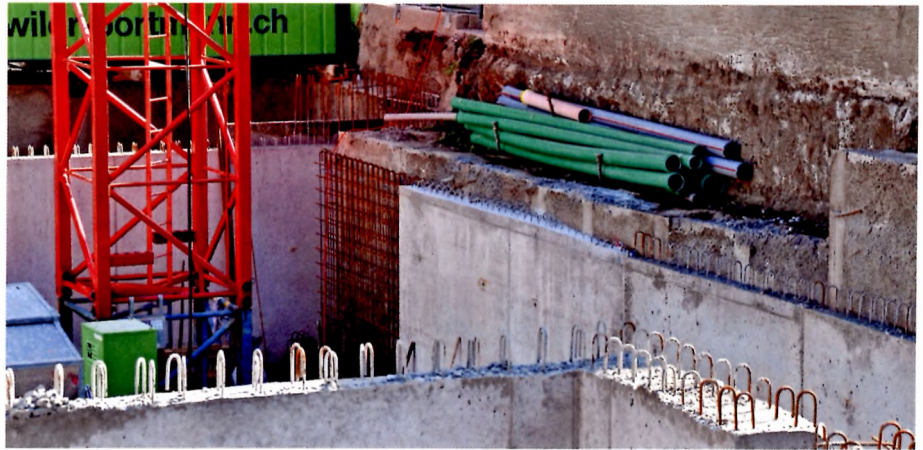
Ohne eine Beststellungsänderung des Bauherren fehlt ein Anspruchgrund für eine Reduktion der Pauschalvergütung. Foto: Susanna Vanek
